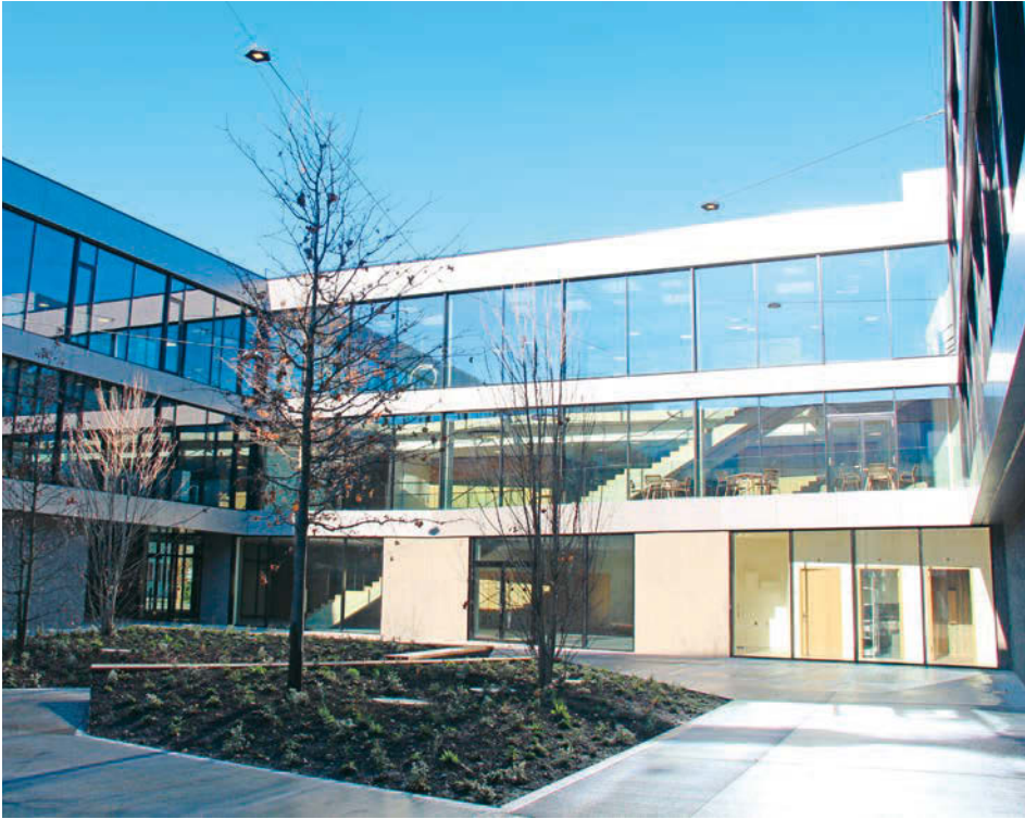
Im gesamten Lichthof kam das Aluminium-Profilsystem FWS 50 mit Einselelementen AWS 75.SI – beide von Jansen-Schüco – zum Einsatz.
