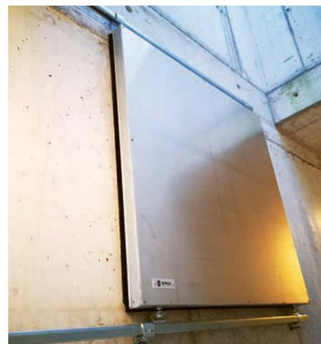
Die stehende Rauchklappe in geschlossener Position. Umlaufende, zusätzliche Bürstendichtungen gewähren die geforderte Rauchdichtheit.
