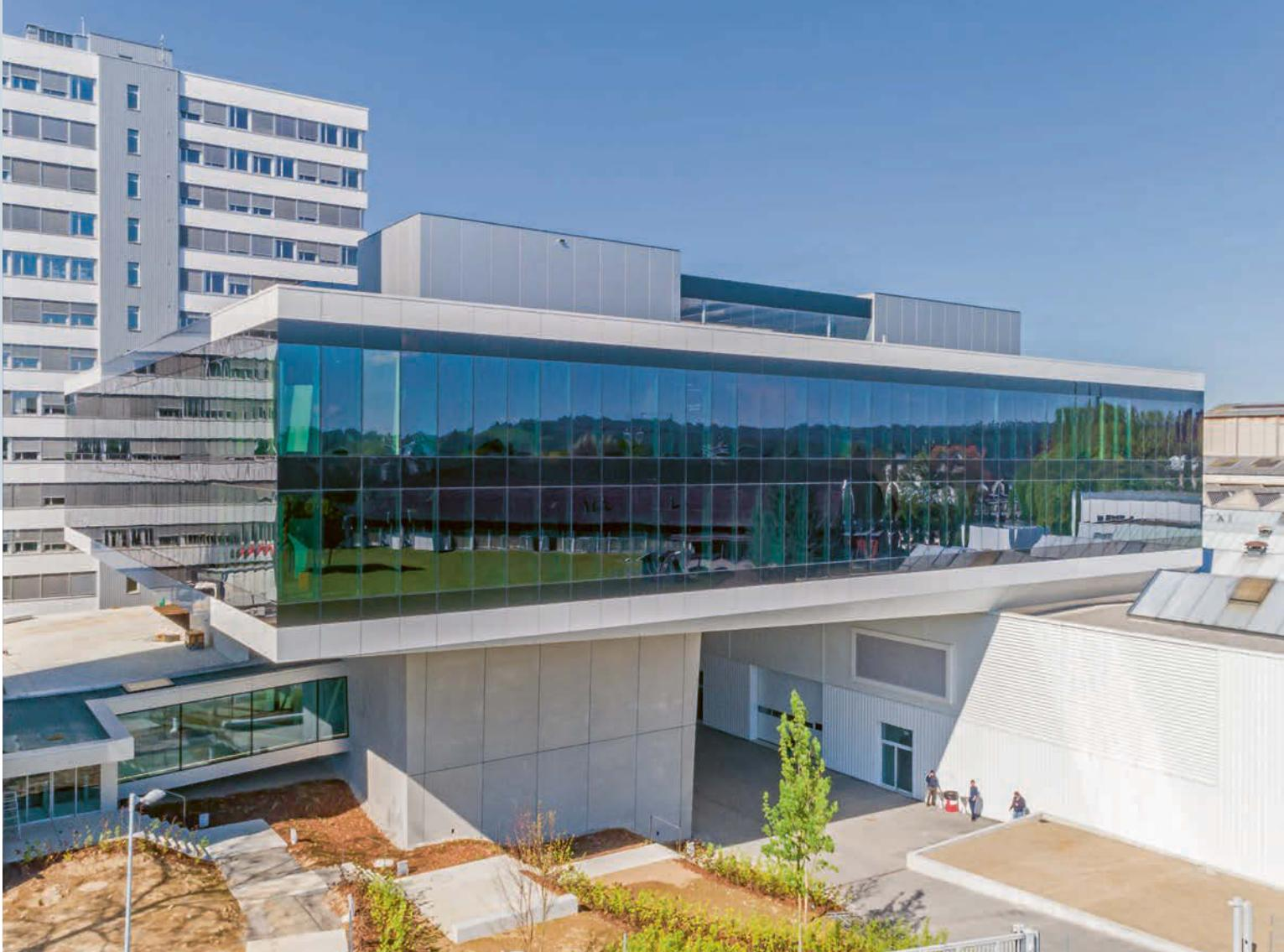
**Das CUBIC mit seinem quadratischen Grundriss von 50 × 50 m ruht auf einem neuen Zugangskern mit Verbindungsbrücken zu den Hochhäusern der Bühler AG.**
