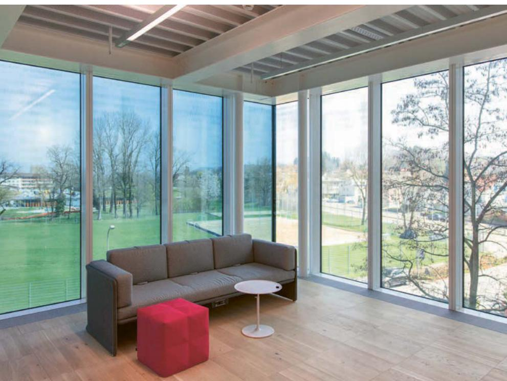
Die elektrochrome Beschichtung der SageGlass-Fassade ermöglicht einen transparenten Sonnenschutz durch Tönung des Glases. Abgedunkelt beträgt die Abschirmung der Sonneneinstrahlung nahezu 100 Prozent.
