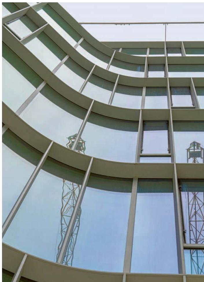
Die aussen aufgeklipsten Aluminiumprofile verleihen der Fassade zusätzliche Materialität, Tiefe und Rhythmus.
