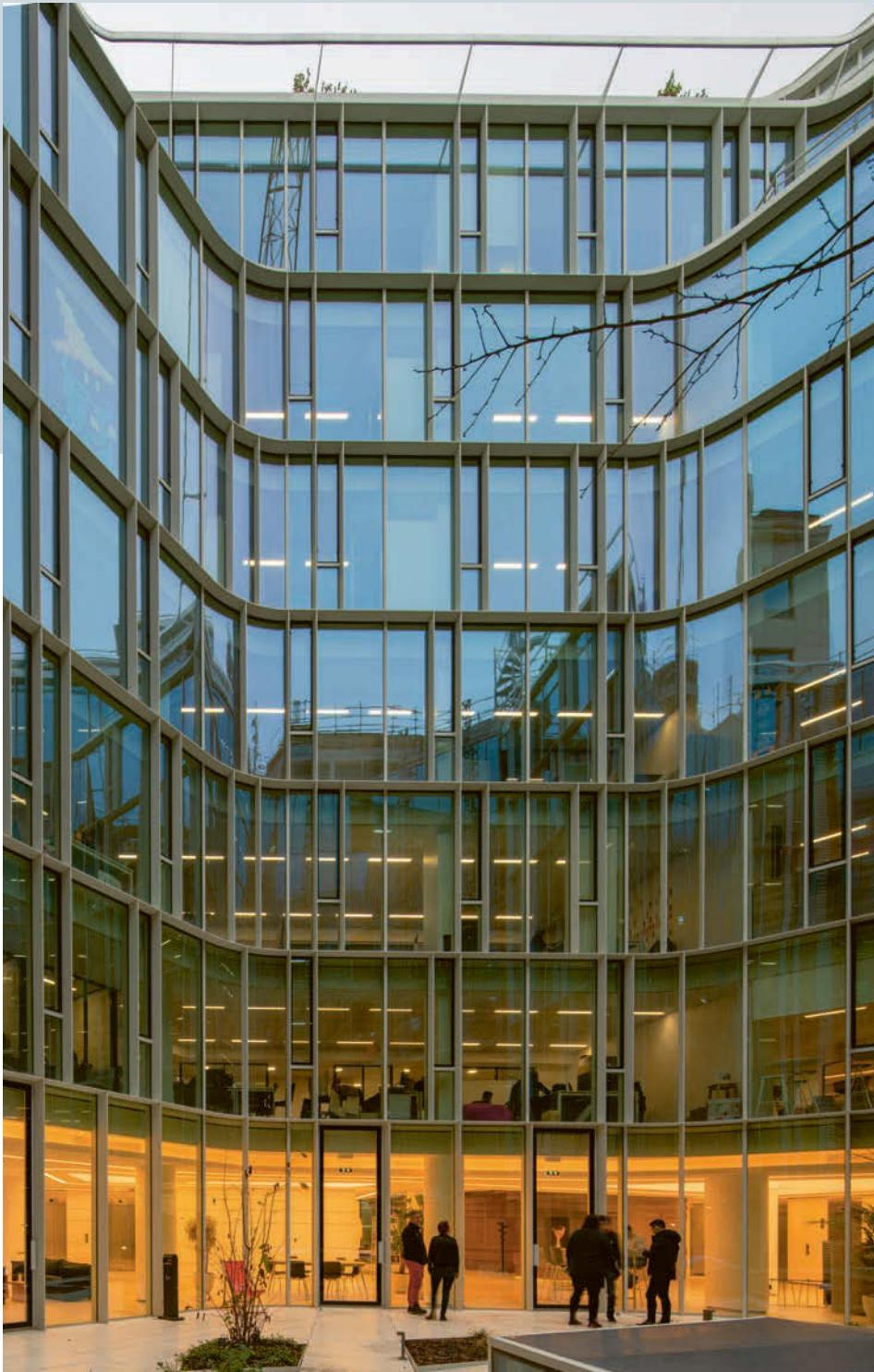
Bei der Sanierung des Pariser Bürogebäudes verwendeten die Architekten bei der Hoffassade ab dem 1. Obergeschoss E30-Brandschutzgläser ISO Pyran von Schott Technical Glass Solutions. Pour la rénovation de l'immeuble de bureaux parisien, les architectes ont utilisé des vitrages pare-feu E30 ISO Pyran de Schott Technical Glass Solutions à partir du 1er étage de la façade de la cour.
