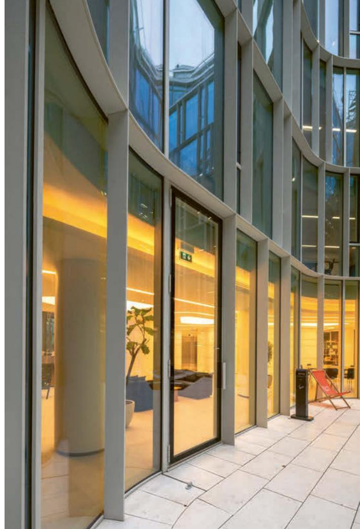
In einer objektbezogenen Brandprüfung gemäss EN 1364 wurden für die Obergeschosse Iso Pyran (plane Ausführung) und Iso Pyran (gebogen) mit dem Aluminiumprofil FW60+ von Schüco getestet.
