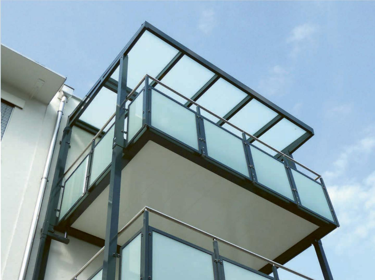
Eine leichte Überdimensionierung der Tragbalken kann insbesondere bei hohen Balkonen durchaus Sinn machen. Die Schwingungen werden deutlich reduziert.
