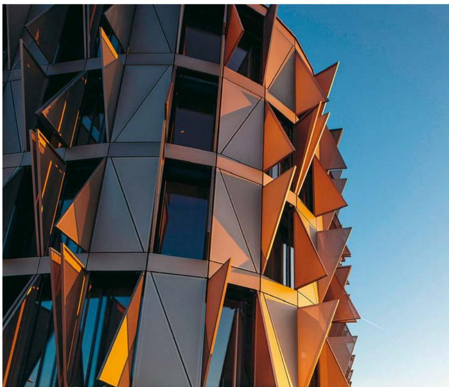
Der dynamische Sonnenschutz aus Aluminium sowie das 3-fach-Isolierglas Silverstar EN2plus sorgen in den Büroräumen für ausgewogenes Tageslicht und angenehme Raumtemperatur.
