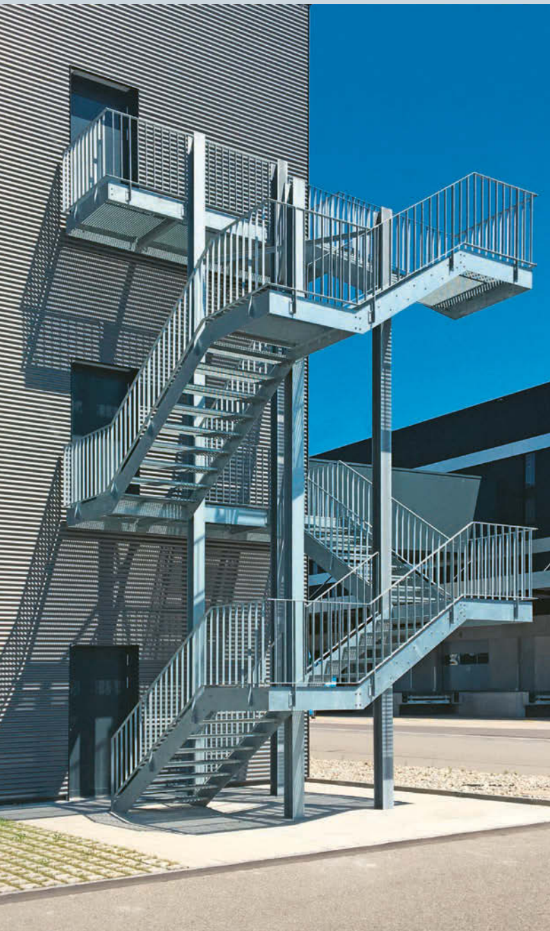
Mehrläufiger Wangentreppenturm als Nottreppe an einem Geschäftshaus. Tour d'escaliers à limons à plusieurs volées comme escalier de secours sur un immeuble commercial.
