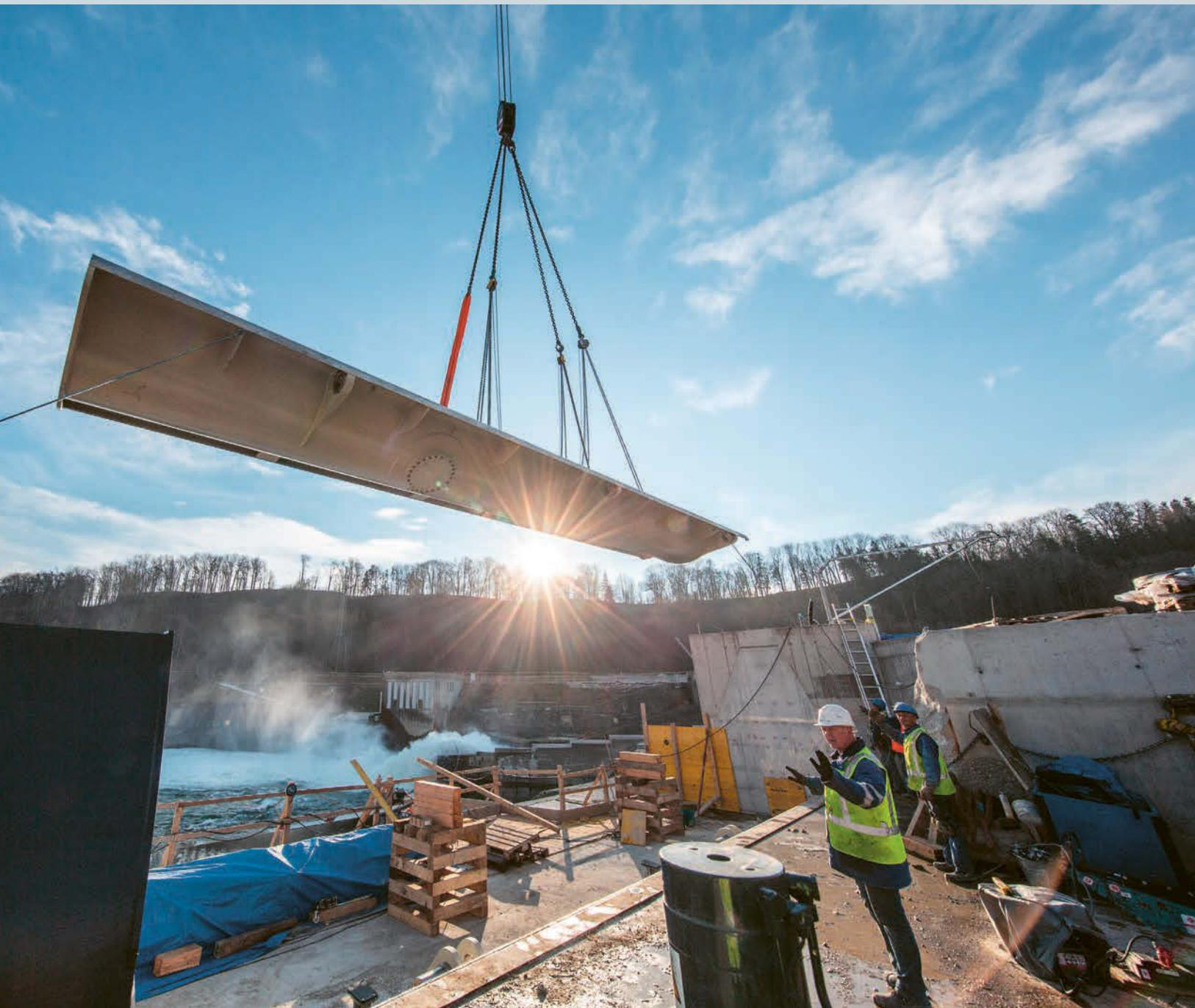
Mit 44 Metern Länge gehört die Fischbauchklappe des Wasserkraftwerks Traunleiten zu den längsten ihrer Art.
