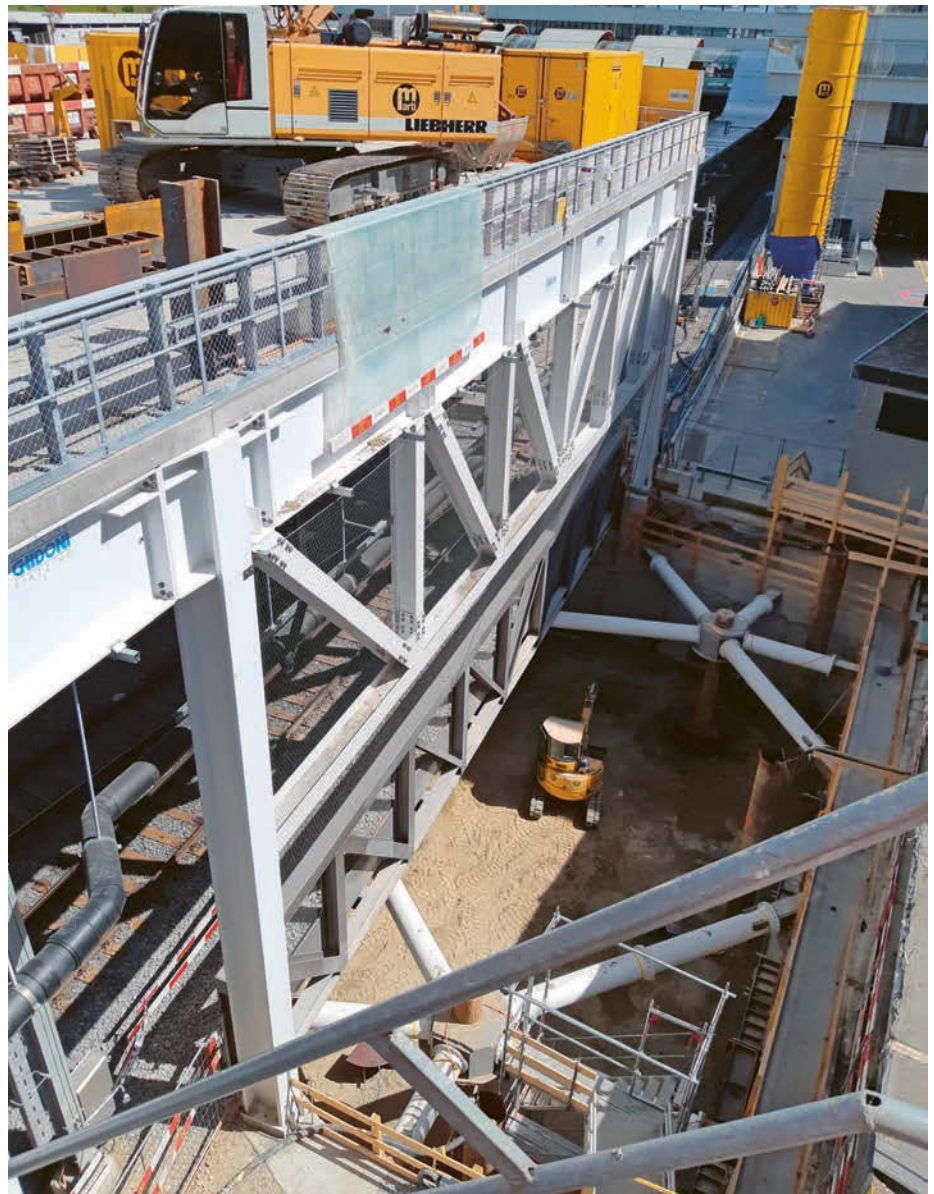
Die Baugrube für den neuen RBS-Bahnhof. Zona di scavo cantiere stazione RBS.
