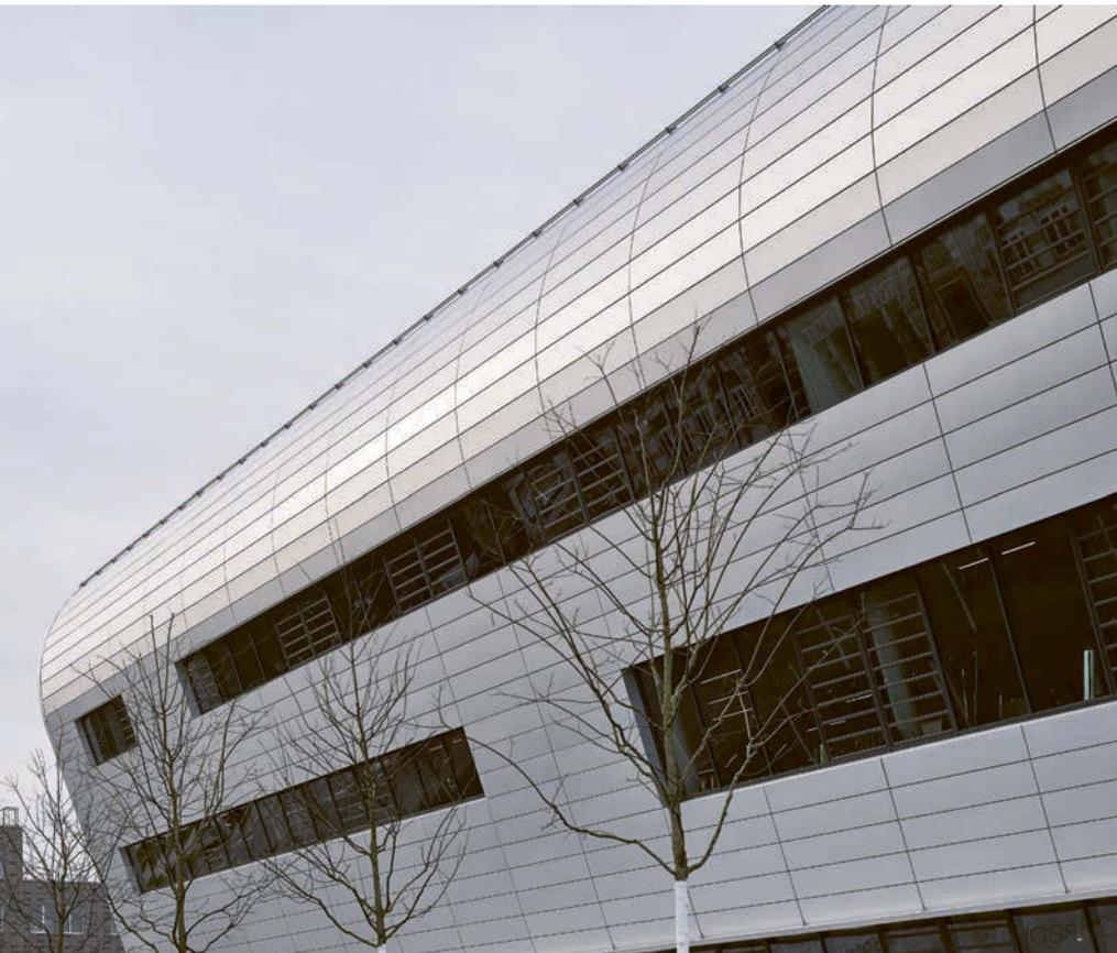
Die FF2-Beschichtung ist UV-beständig, schmutzabweisend, leicht zu reinigen sowie glanz- und witterungsbeständig.
