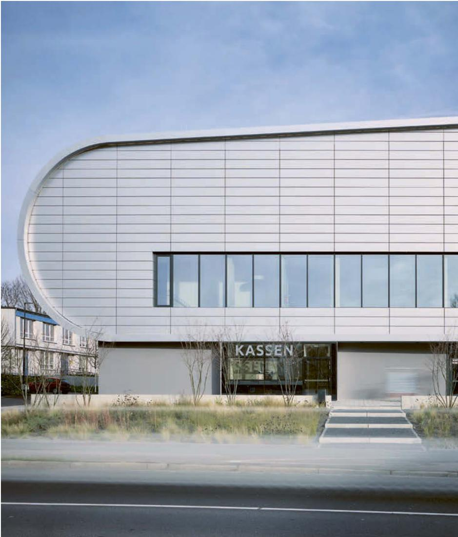
Für die horizontal verlegten Fassadenelemente kamen rund 6000 m<sup>2</sup> Novelis FF2 Farbaluminium in 2 mm Dicke zum Einsatz.
