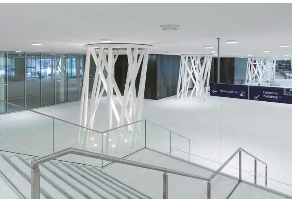
Das verwendete Ganzglasgeländersystem Balardo Steel (hinten) wurde auf einer Gesamtlänge von 67 Metern verbaut.
