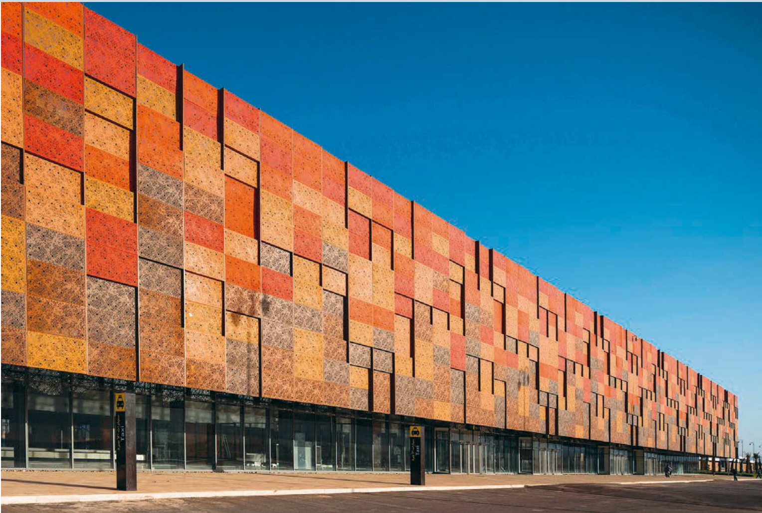
Perforierte Metallpaneele widerspiegeln die Farben der Wüste. Les panneaux métalliques perforés reflètent les couleurs du désert.
