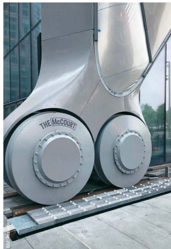
Die mannshohen Räder gewähren ein sicheres Verfahren. Les roues de hauteur d'homme veillent à un déplacement sûr.
