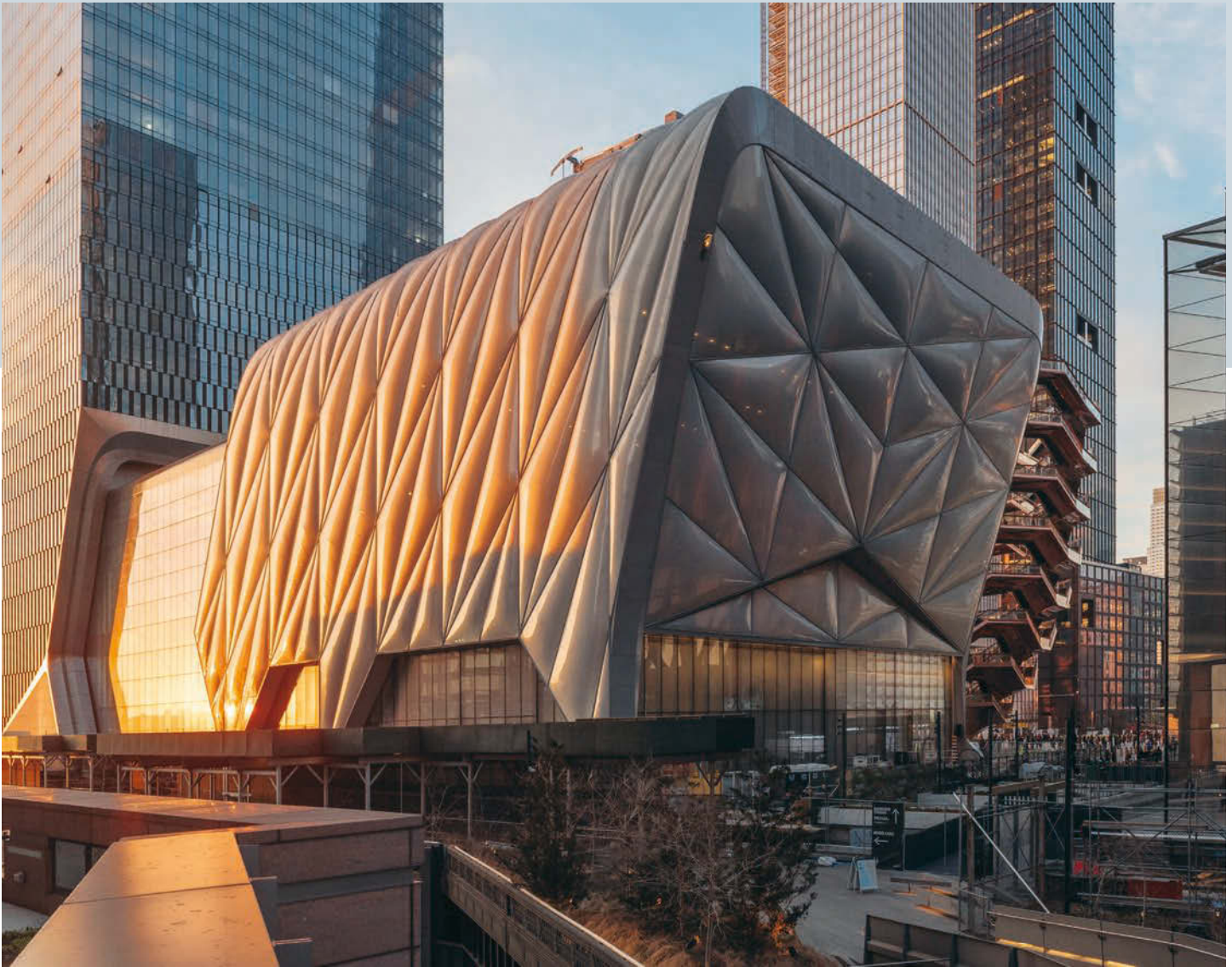
«The Shed», das kompakte, stählerne Bauwerk mit der silbrig-glänzenden Folienkissenhaut lässt sich bedarfsspezifisch nach innen oder aussen fahren. « The Shed » peut être agrandi grâce à sa coque coulissante aux reflets argentés.
