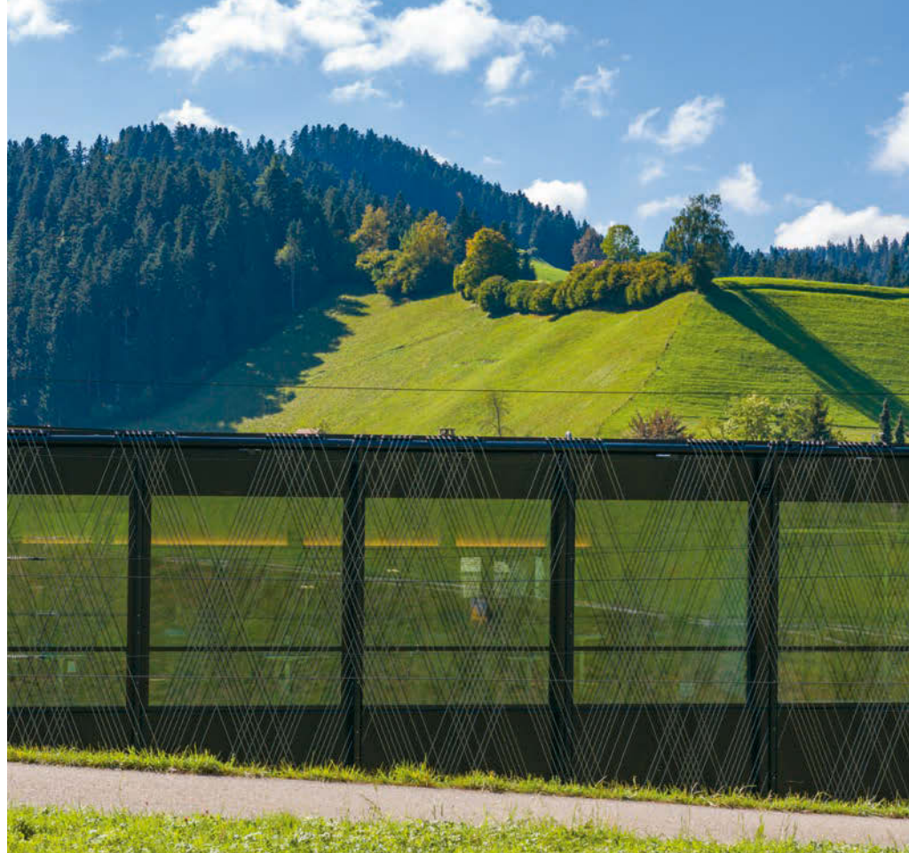
Seilfassade am Erweiterungsbau. Façade câblée de l'extension
