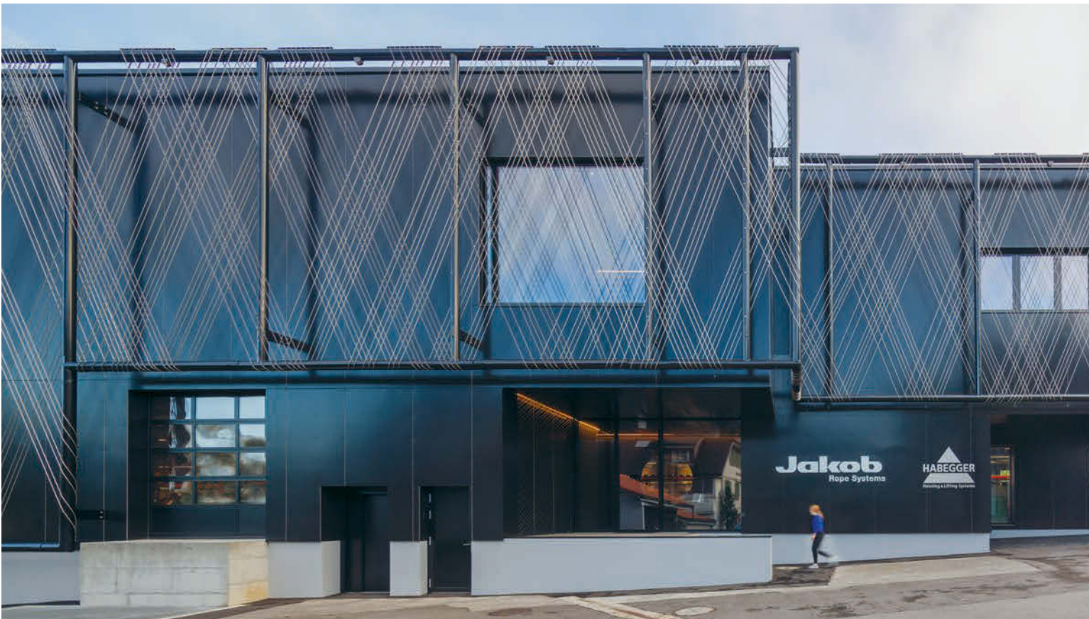
Seilfassade und Rahmenkonstruktion am Haupteingang.
