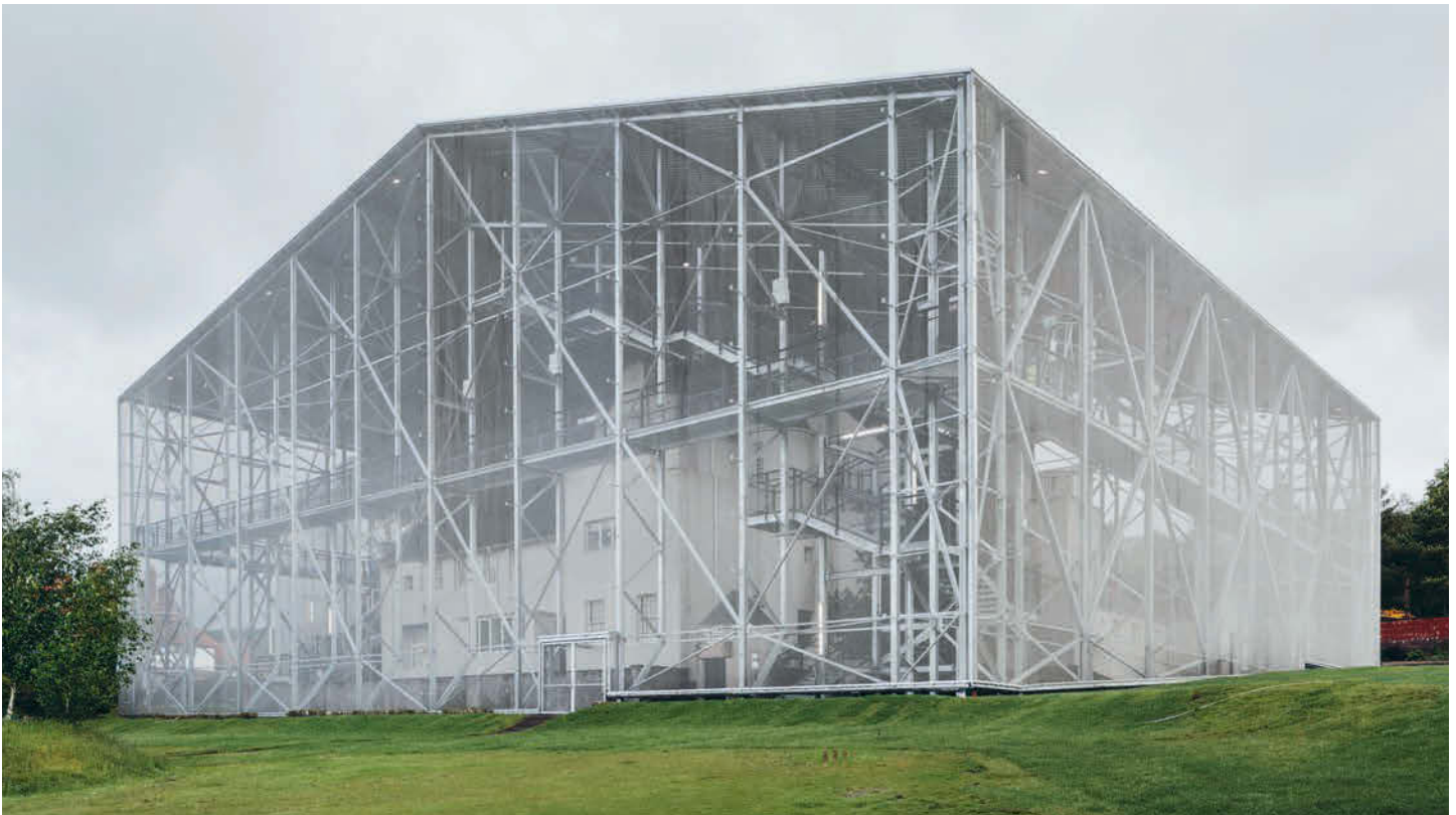
«The Hill House Box» - ein semitransparenter Pavillon im Stahlgeflecht. « The Hill House Box », un pavillon semi-transparent en treillis d'acier.
