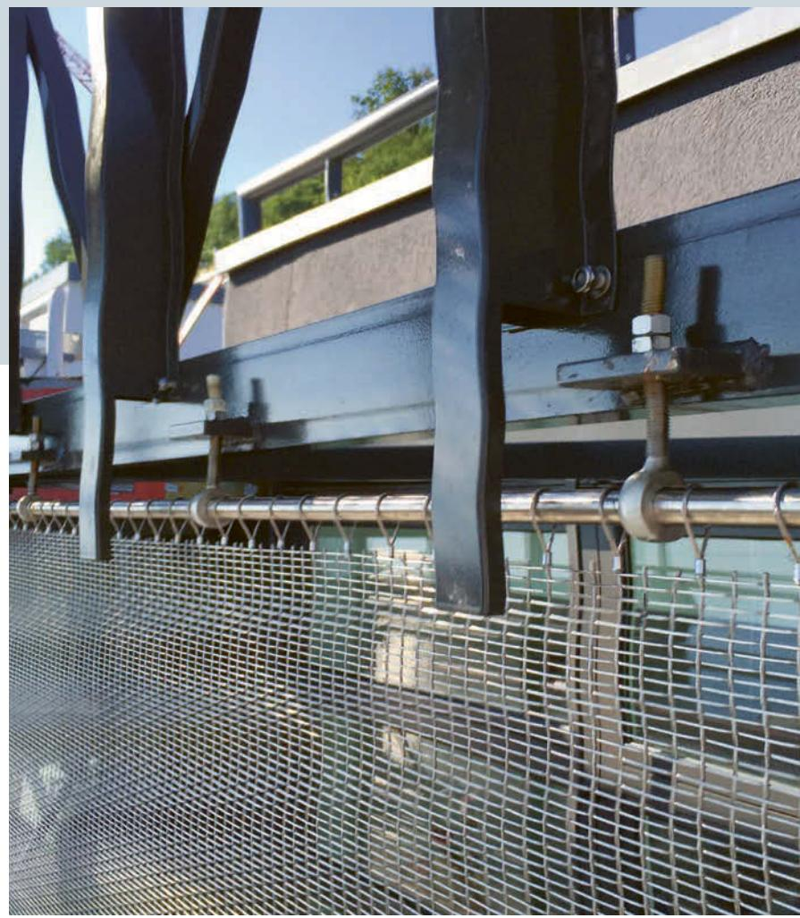
**Aufhängesystem oben:** Höhenverstellbare Konsole ermöglichen den horizontalen Tragstab exakt auszurichten. Gut zu erkennen, die Aufhängeschlaufen des Gewebes.
