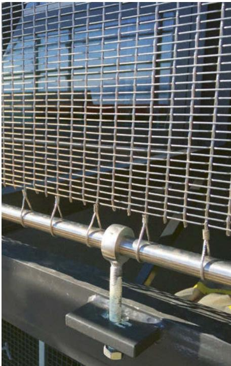
**Spannsystem unten:** Eine verstellbare Spannvorrichtung ermöglicht einen ausgeglichenen Zug zur Spannung des Metallgewebes.
