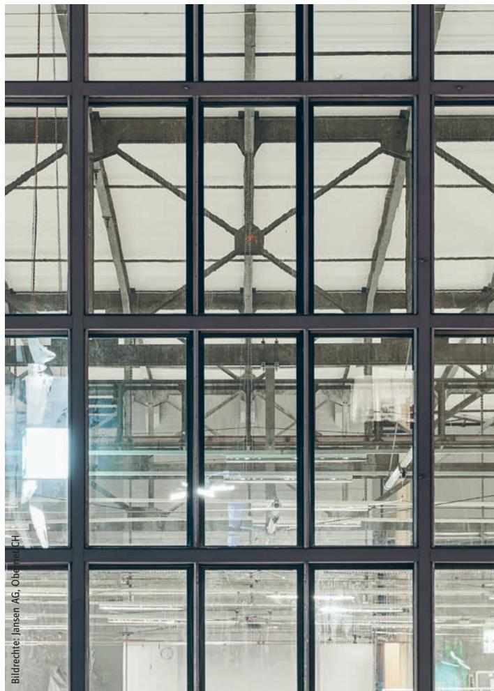
Im Fensterbereich wurde innenseitig eine zeitgemäss Stahlelementfassade mit 3-fach-Isolierglas und Sonnenschutzanlagen montiert. Fenster: System Janisol Primo.
