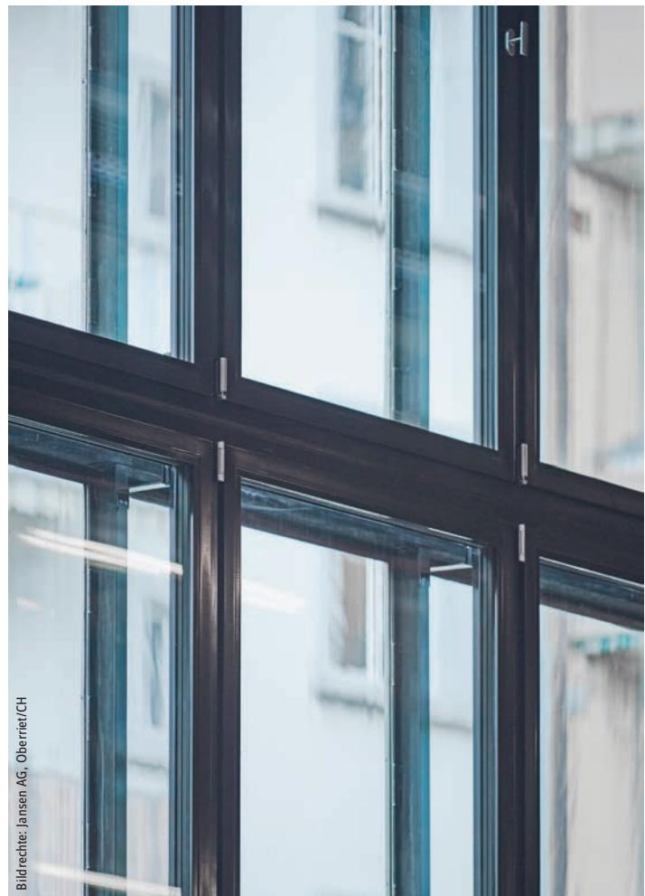
Mit nur 60 mm Bautiefe erzielen die innen montierten, thermisch getrennten Stahlprofile hervorragende Wärmedämmwerte.
