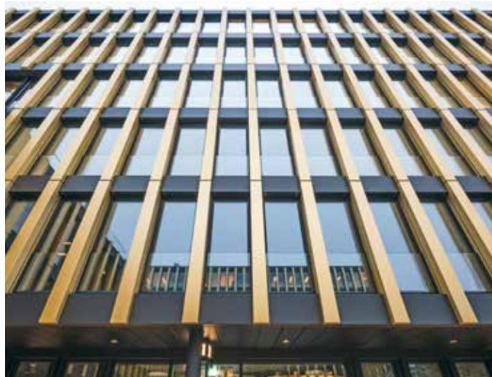
Die Elementfassade besteht aus raumhohen Fenstern in Aluminium mit Verkleidungen aus Aluminiumblech: Die Verglasung ist mit 3-fach-Isolierglas ausgeführt.
