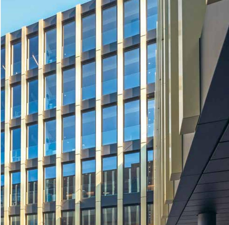
Die Fassade ist geprägt von eloxierten Metallbändern in Gold. Sie verlaufen vertikal an der Gebäudehülle und erzeugen eine repetitive Rasterung.
