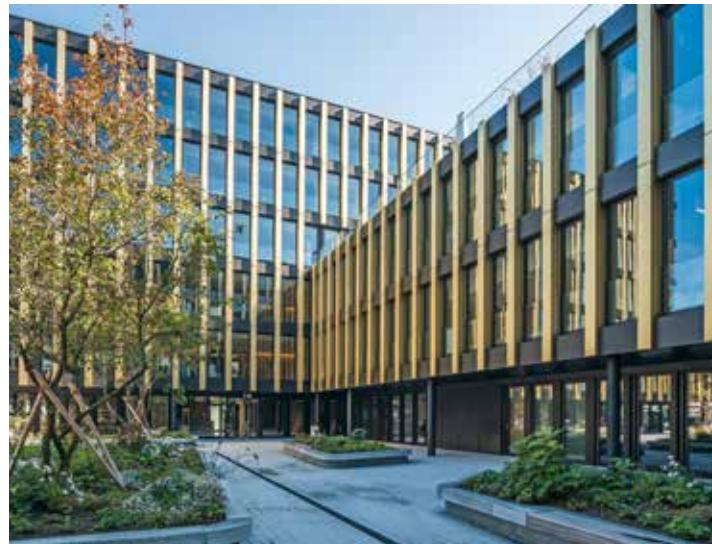
Drei der Gebäudefronten des Quadrolith sind als Pfosten-Riegel-Fassade in FWS 60.SI ausgeführt - insgesamt 77 Tonnen Aluminiumblech wurden verbaut.
