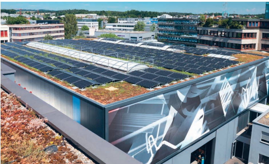
Mit 472 Ost-West-ausgerichteten Solarmodulen produziert Burri 136 500 kWh pro Jahr und deckt damit mehr als 50% des Eigenbedarfs ab.
