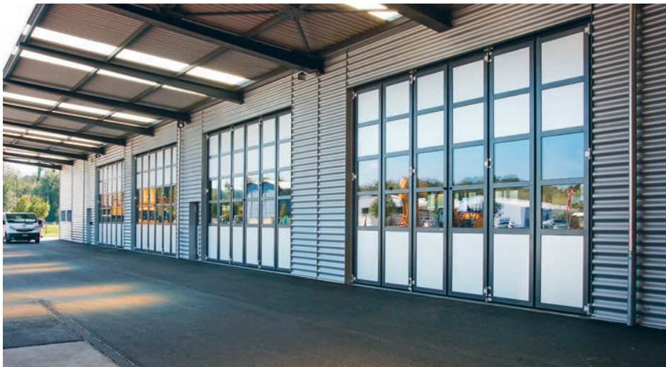
Falt-Schiebe-Tore am Ergänzungsbau des AM Suisse in Aarberg.
