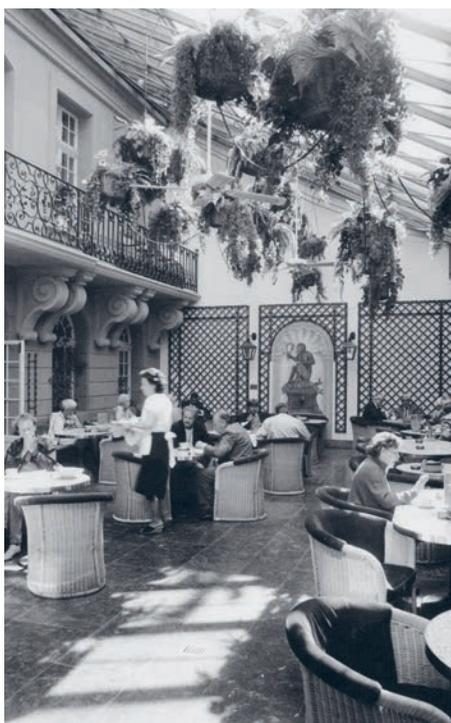
Abbildung 1: Das ehemalige Glasdach war als stark geneigtes Pultdach in die ursprüngliche Hofsituation eingepasst.
