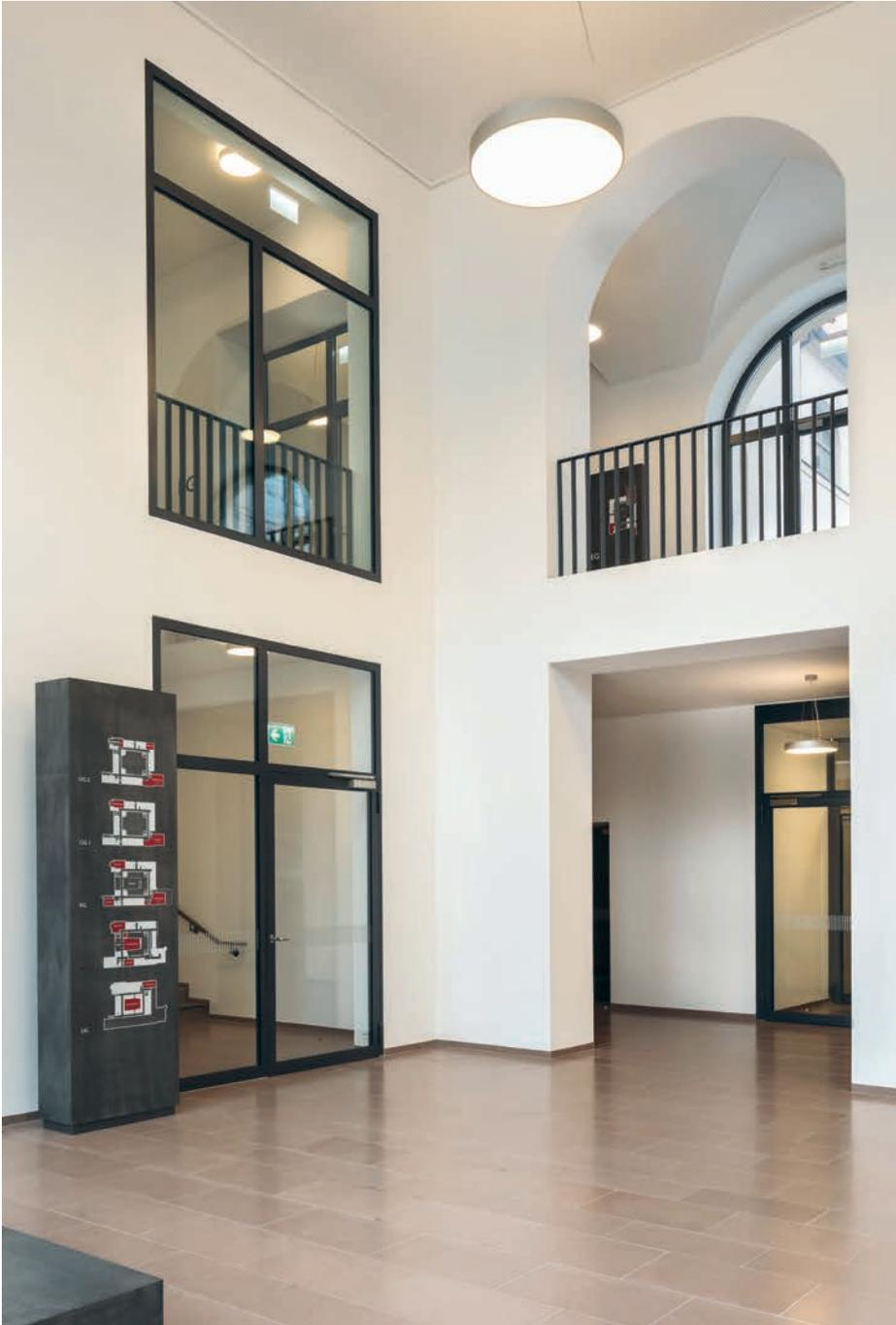
Auch das Brandschutzkonzept musste der neuen Nutzung angepasst werden. Die umlaufenden Flure der vier Gebäudeflügel wurden in Brandschutzabschnitte unterteilt und mit verglasten Brand- und Rauchschutztüren geschlossen.
