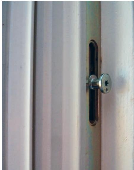
Fenster lassen sich am besten durch verdeckte Sicherheitskomponenten nachrüsten. Herkömmliche Rollzapfenbeschläge werden gegen zertifizierte Pilzkopfzapfen ausgetauscht.
