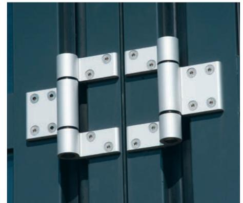
Gebäudetrennung: Links die unisolierte, rechts die isolierte Ausführung bei optischer Gleichheit.
