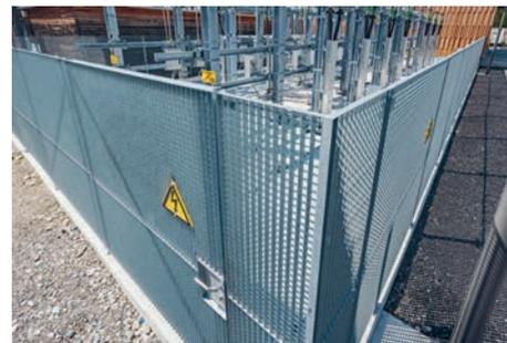
Um in optischer Hinsicht der bestehenden Holzfassade des angrenzenden Gebäudes nahezukommen, wurden die Roste seitenverkehrt angebracht, sodass die vertikalen Linien auf der Aussenseite zeichnen.
