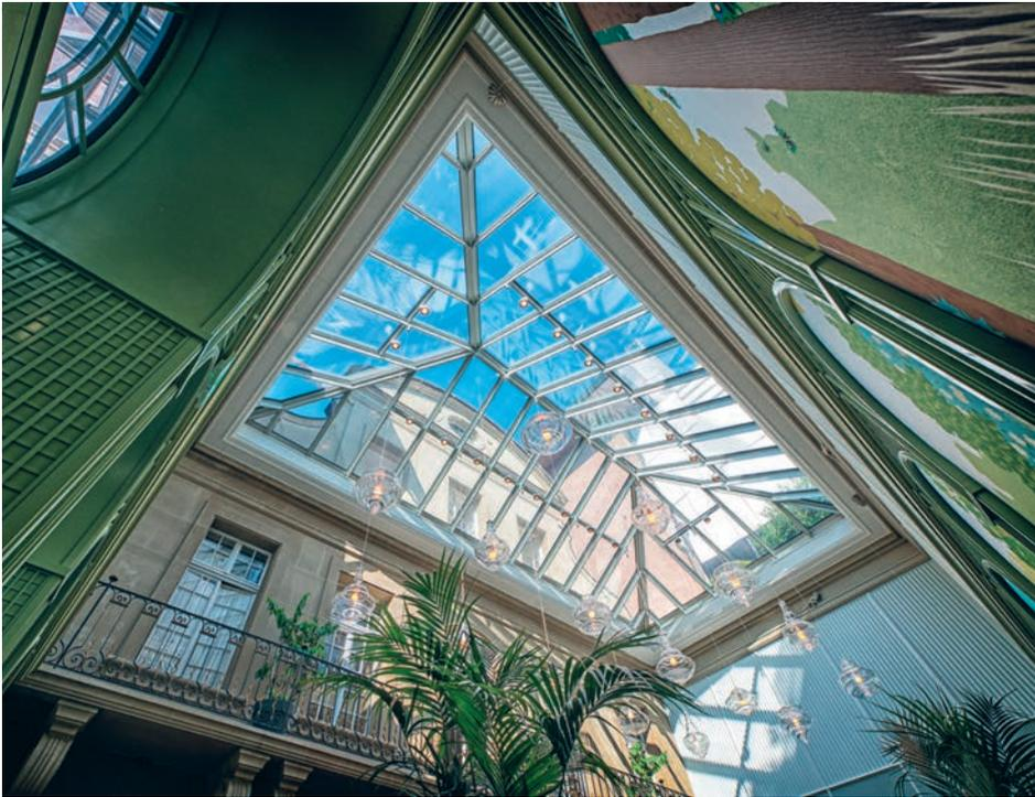
Abbildung 3: Der verzogene, nicht rechtwinklige Grundriss erforderte geometrische Höchstleistungen bei der Planung sowie bei der Herstellung und Montage.
