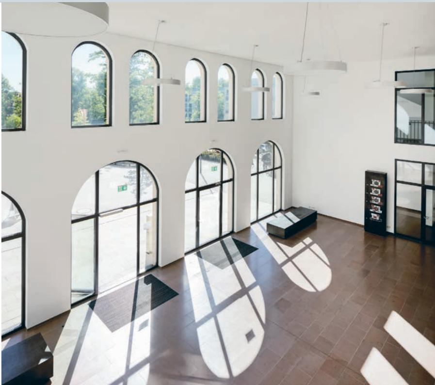
Für den neuen Haupteingang wurde die zuvor geschlossene Fassade mit vier grossformatigen Portalen zu einem einladenden Entrée geöffnet und die Geschosdecke zwischen UG und EG entfernt, sodass ein liches Foyer entstand.
