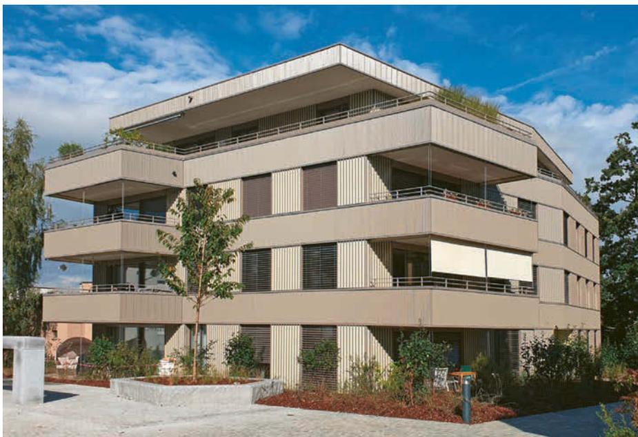
Die Aussenhaut der Überbauung Burgmattstrasse besteht weitgehend aus Blech. Die 2D-Pläne der Architekten wurden in die HiCAD-Konstruktion integriert und mittels Translation dreidimensional verfügbar gemacht.
