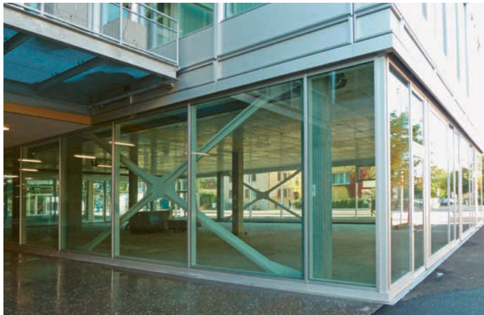
Die Pfosten-Riegel-Konstruktionen sind modulmässig aufgebaut und ermöglichen auch zu einem späteren Zeitpunkt den Einbau von Türelementen. Les poteaux-traverses sont modulables et permettent aussi d'intégrer ultérieurement des modules de portes.
