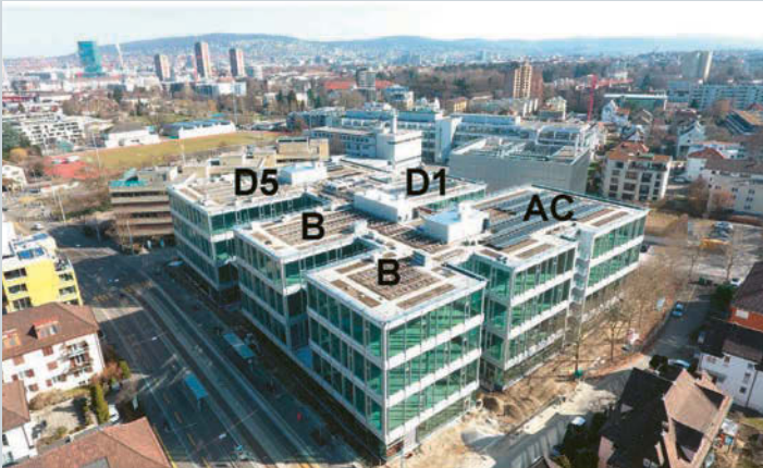
Links, Sicht von oben. Gut zu erkennen die sechs gläsernen Kuben. Rechts die unter den Kuben liegenden vier Raumgeometrien des Erdgeschosses mit den Pfosten-Riegel-Verglasungen. À gauche, vue du ciel. On distingue clairement les six cubes en verre. À droite, les quatre volumes différents du rez-de-chaussée en façade poteaux-traverses.
