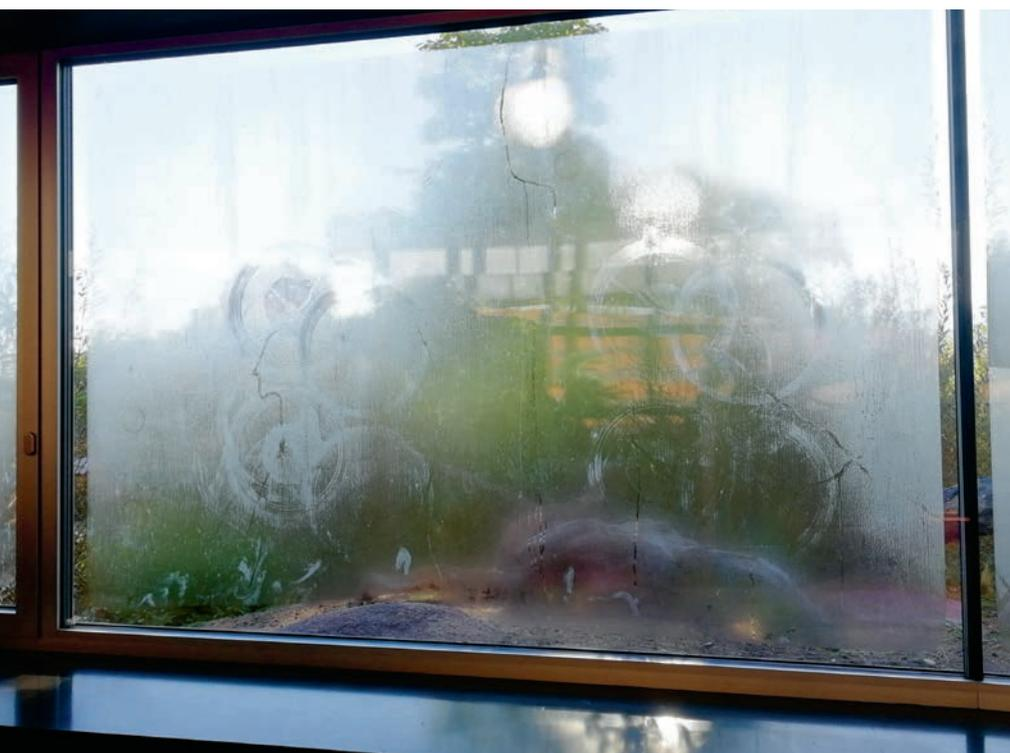
Verglasung mit Aussenkondensat und sichtbaren Saugerabdrücken (Quelle: SIGAB).
