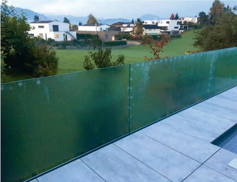
Ganzglasgeländer mit umlaufend sichtbaren Unterschieden der Benetzbarkeit (Quelle: SIGAB).
