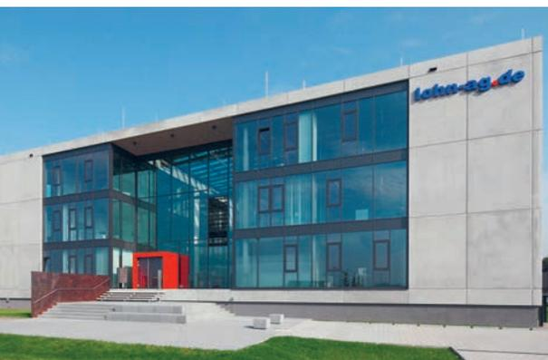
Die Aussenhülle ist hochwärmegedämmt und das Innere ist mit thermoaktiven Bauteilen ausgestattet.
