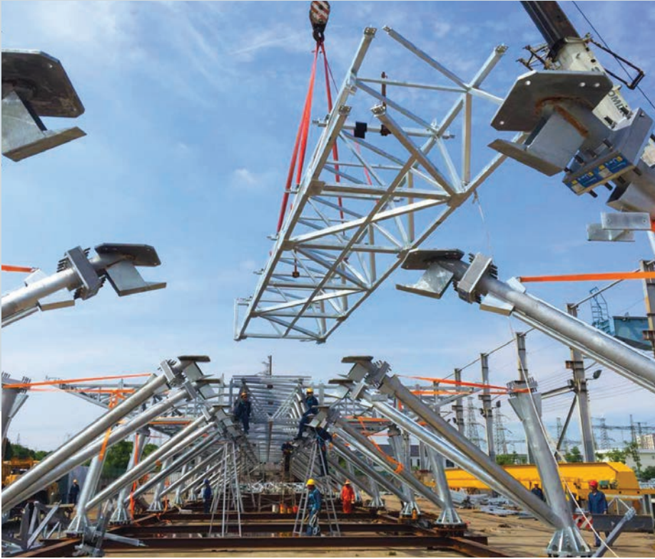
Une grue de chantier positionne un support de sol sur le système de poteaux en acier assemblé avec des éléments Isokorb type KST raccordés.
