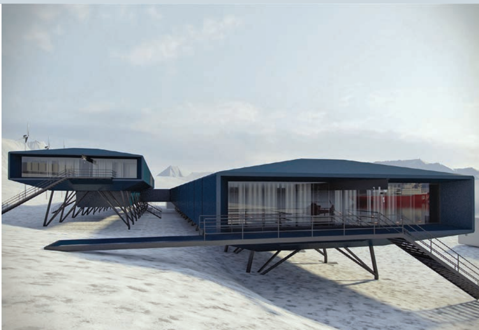
Le bloc supérieur de la base antarctique Comandante Ferraz regroupe des cabines de couchage, des espaces de repas et de vie, tandis que les laboratoires, espaces d'exploitation et de maintenance se trouvent dans le bloc du bas.
