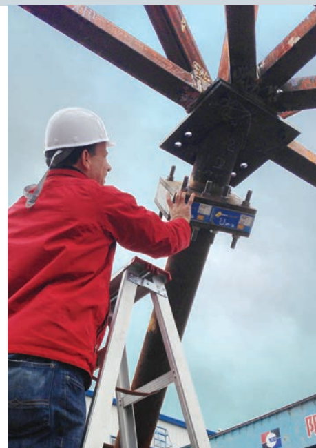
Un ingénieur contrôle un élément Isokorb type KST raccordé utilisé pour la séparation thermique et pour minimiser les déperditions thermiques sur le système de poteaux en acier.
