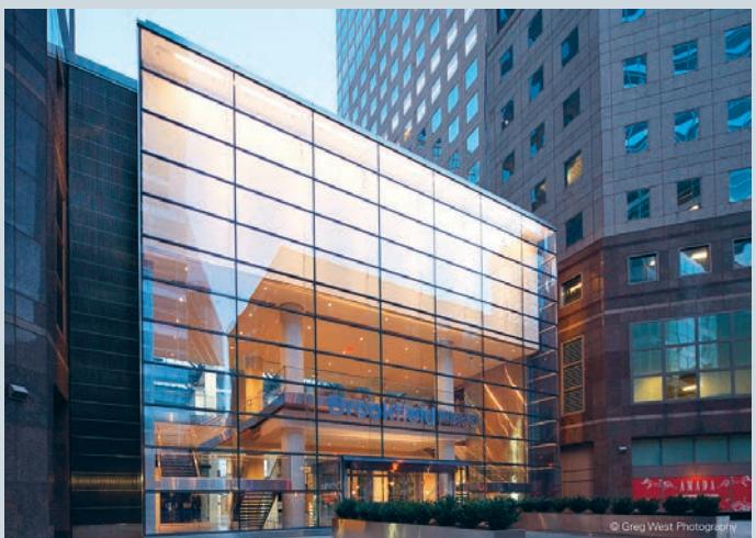
Die zur Vesey Street ausgerichtete Ganzglasfassade mit einer Breite von 21 m und einer Höhe von 17 m.
