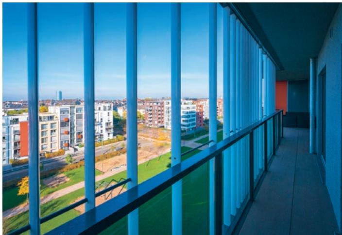
Bestehend aus hochwertigen, stranggepressten Aluminiumhohlkörperlamellen ist das System besonders korrosionsfest undwitterungsbeständig. Composé de lamelles à corps creux en aluminium filées à la presse de grande qualité, le système est particulièrement résistant à la corrosion et aux intempéries.
