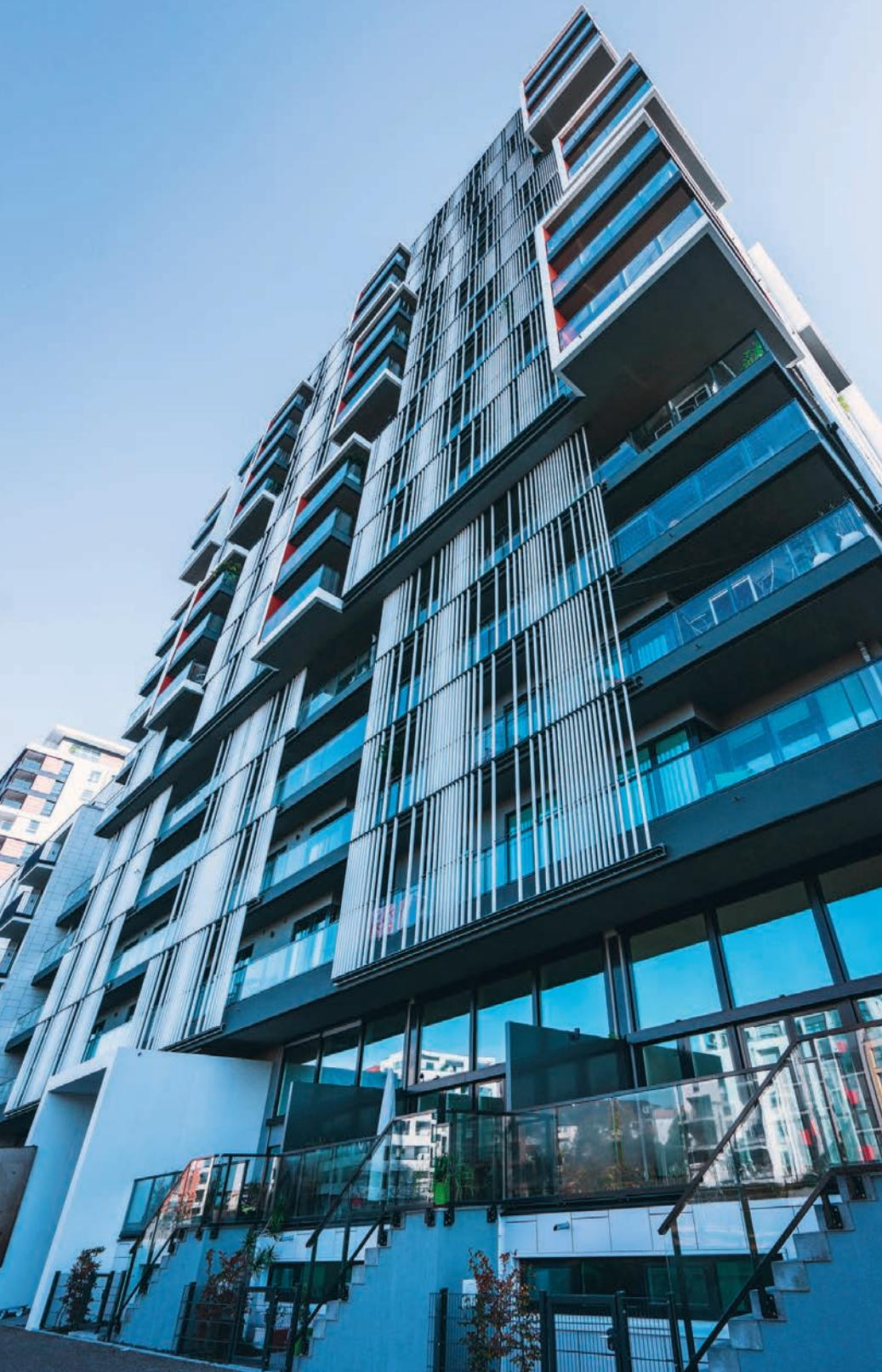
lamellen vom Typ Solarfin von Colt verleihen den vorgelagerten Terrassen eine zweite Hülle. Aus dieser ragen im Turm mehrgeschossige «Kisten» mit den Terrassen hervor, die durch ein massives Bauteil eingerahmt sind.
