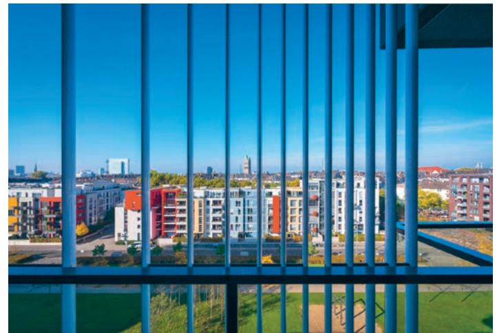
Die durchlässigen und unterschiedlich dicht stehenden Aluminiumlamellen verleihen den vorgelagerten Terrassen eine zweite Hülle. Les lamelles en aluminium verticales d'épaisseurs différentes et perméables confèrent une seconde enveloppe aux terrasses en saillie.
