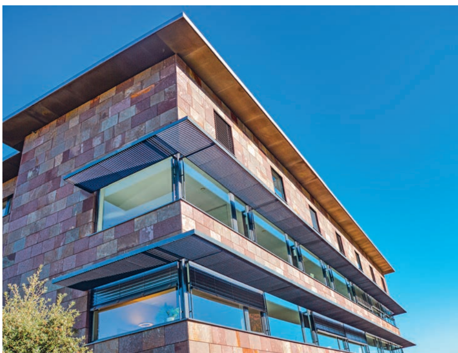
Horizontal auskragende Beschattung für die Büroräume aus Aluminium-Vollrosten.
