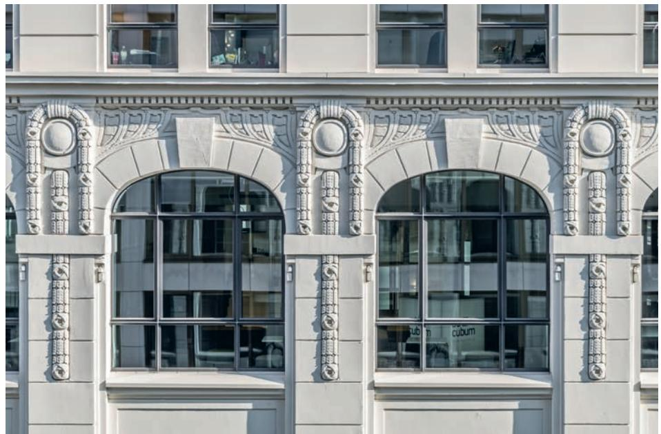
Mit den schmalen Profilansichtsbreiten von lediglich 25 beziehungsweise 40 mm bei Festverglasungen und einer Bautiefe von 60 mm konnten feine, jedoch stabile Fenster mit einem hohen Glasanteil und bester Wärmedämmung realisiert werden.
