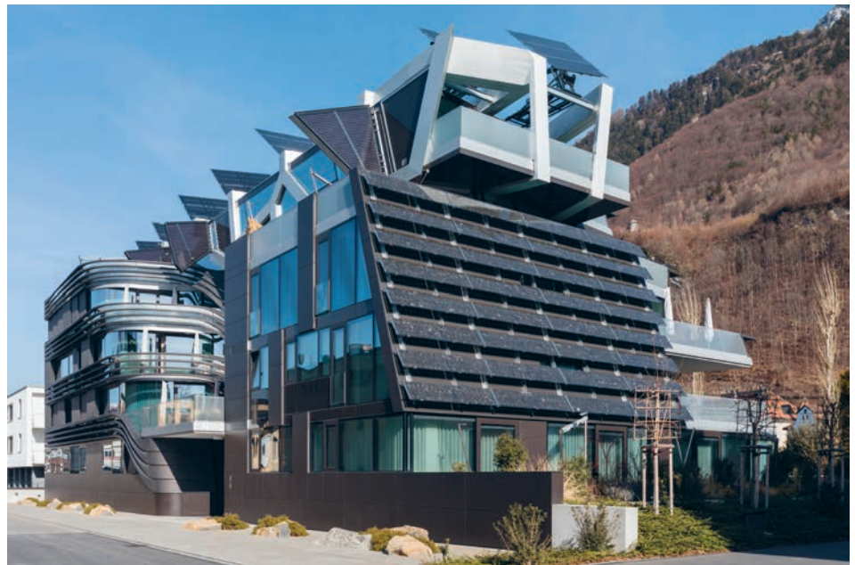
Bei der Fassadenplanung des futuristischen Active Energy Building «Marxer» in Liechtenstein boten die Tools von HiCAD grosse Vorteile.
