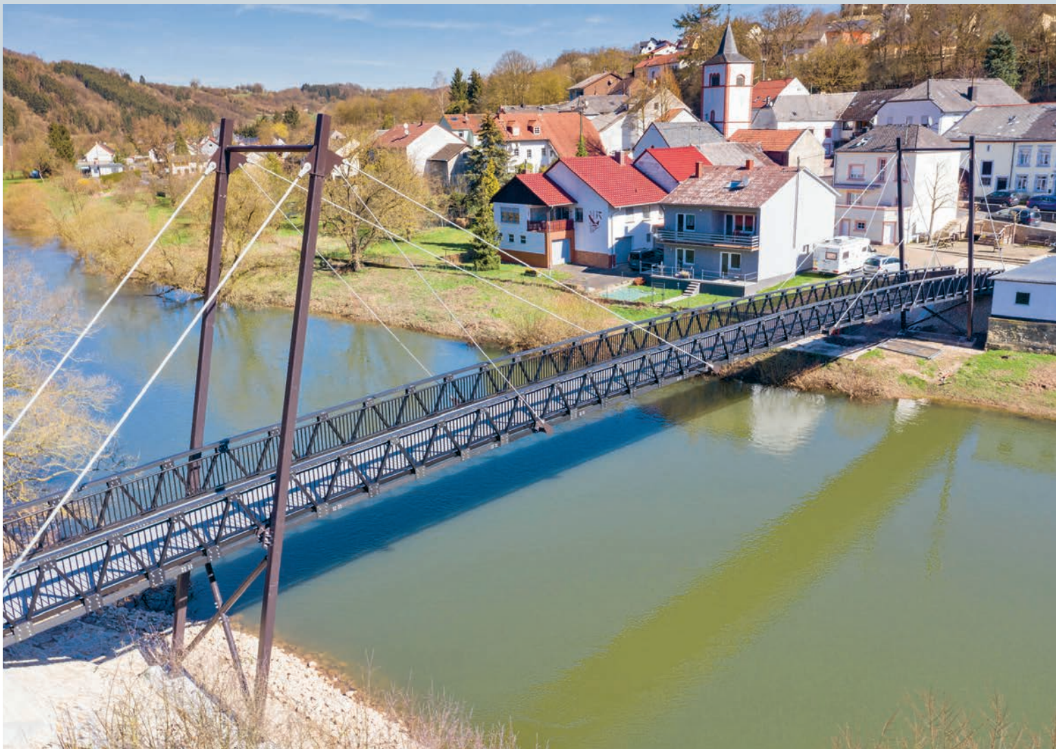
Die 66 Meter lange und 3,3 Meter breite Schrägseilbrücke ist an zwei Stahlpylonen abgespannt und für zwölf Tonnen Gesamtgewicht ausgelegt. Long de 66 mètres et large de 3,3 mètres, le pont à haubans est tendu sur deux pylônes d'acier et peut supporter un poids total de douze tonnes.
