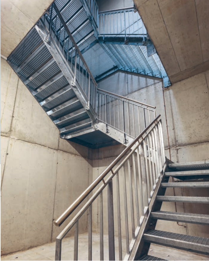
Die vertikale Kraftabtragung erfolgt auch über die Innenwangen. Le transfert vertical des forces se fait aussi via les limons intérieurs.
