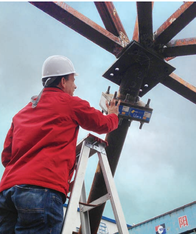
Ein Ingenieur prüft ein angeflanshtes Isokorb-Element des Typs KST zur thermischen Trennung, das zur Minimierung von Wärmeverlusten an Stahlstützensystem montiert wurde, das die Comandante-Ferraz-Antarktisstation über den gefrorenen Boden hält.
