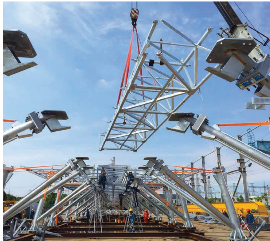
Ein Baukran positioniert einen Bodenträger über dem Stahlstützensystem, das mit angeflanshten Isokorb-Elementen des Typs KST.
