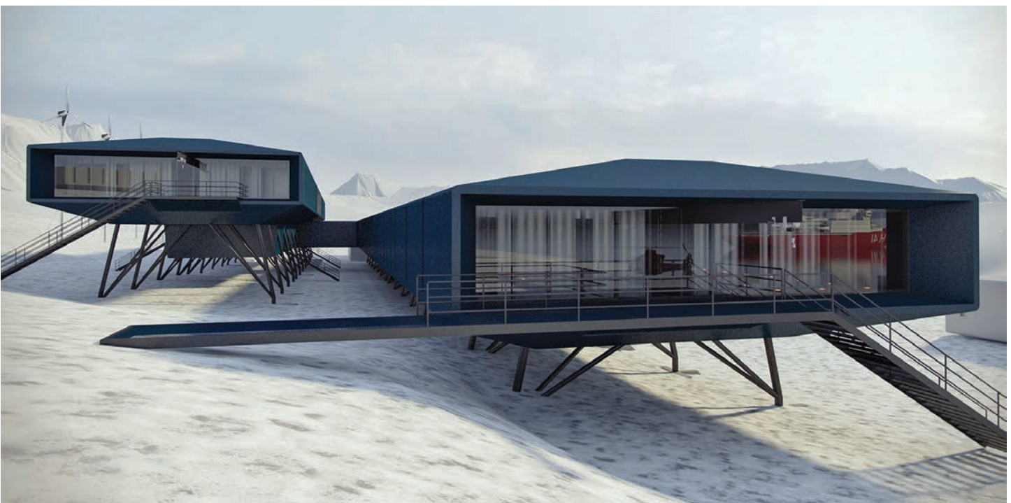
Im oberen Block der Comandante-Ferraz-Antarktisstation sind Schlafkabinen, Speise- und Wohnbereiche untergebracht, während sich Labore, Betriebs- und Wartungsbereiche im unteren Block befinden.
