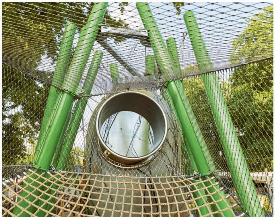
Eine Kombination aus Faserseilnetz und dem Edelstahlgeflecht Webnet kam zur Anwendung. Une combinaison de filets en cordages de fibre et de câbles en inox Webnet a été employée.
