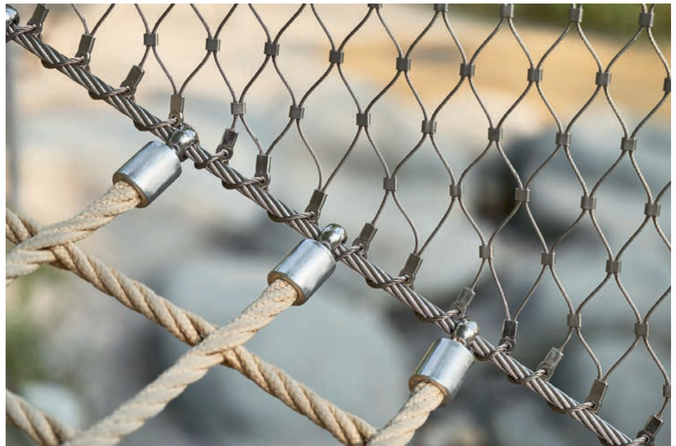
Das Faserseilnetz besteht aus Herkulestauwerk. In jeder Seillitze steckt ein harter Kern aus Stahldraht. Le filet en cordages de fibre est formé de cordes Herkules dotées d'une âme dure en câble d'acier.
