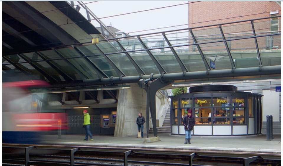
Die Front- und Kundenseite ist gegen die Perrons gerichtet. Le côté avant destiné aux clients est orienté vers les quais.
