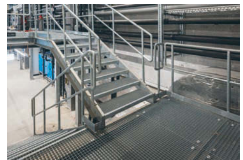
Fussleisten von 100 mm Höhe verhindern, dass Gegenstände oder Personen herunterfallen können.
