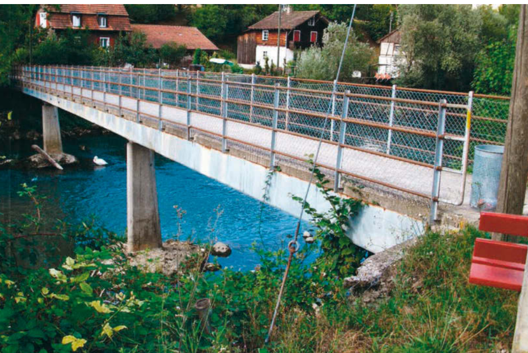
Die bestehende alte Fussgängerbrücke über die Birs in der Gemeinde Grellingen BL.
