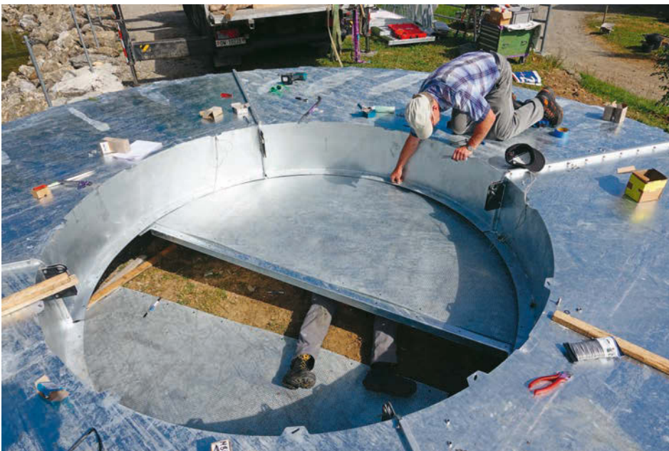
Zusammenbau am See. Die Lochbleche werden eingesetzt. Assemblage sur le lac. Mise en place des tôles perforées.
