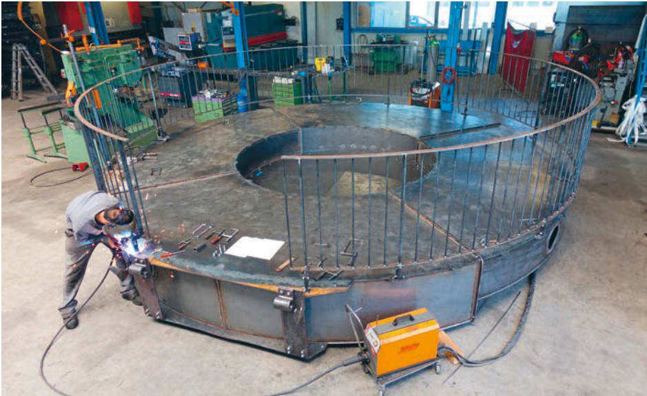
Zusammenbau im Werk. Die Gelenklager im Vordergrund. Assemblage en usine. Au premier plan, les rotules.
