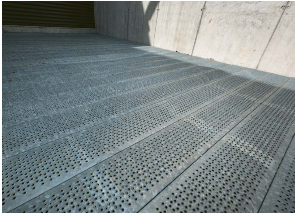
Die Blechprofilroste verfügen über eine spezielle Lochung und lassen einerseits austretende Flüssigkeit schnell in die Auffangwanne fließen und andererseits reduzieren sie die Sauerstoffzufuhr und verhindern somit ein Brennen der Flüssigkeit.
