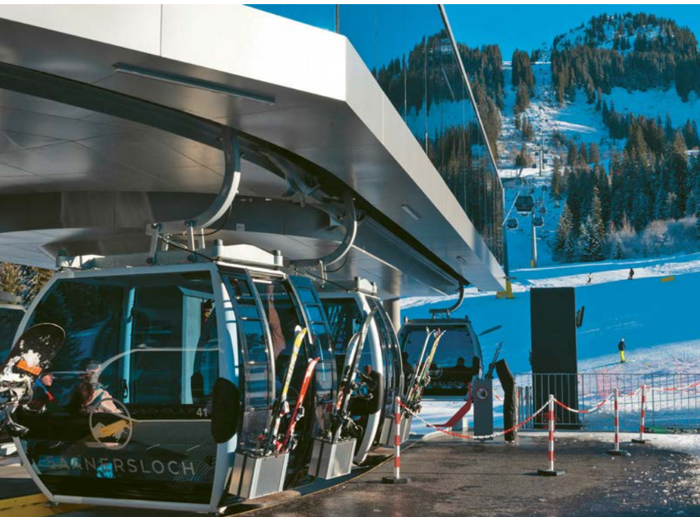
Die Glasfarbe in Dach und Fassade spiegelt sich auf angenehme Weise in den Seilbahngondeln. La couleur du verre du toit et de la façade se reflète agréablement sur les cabines.
