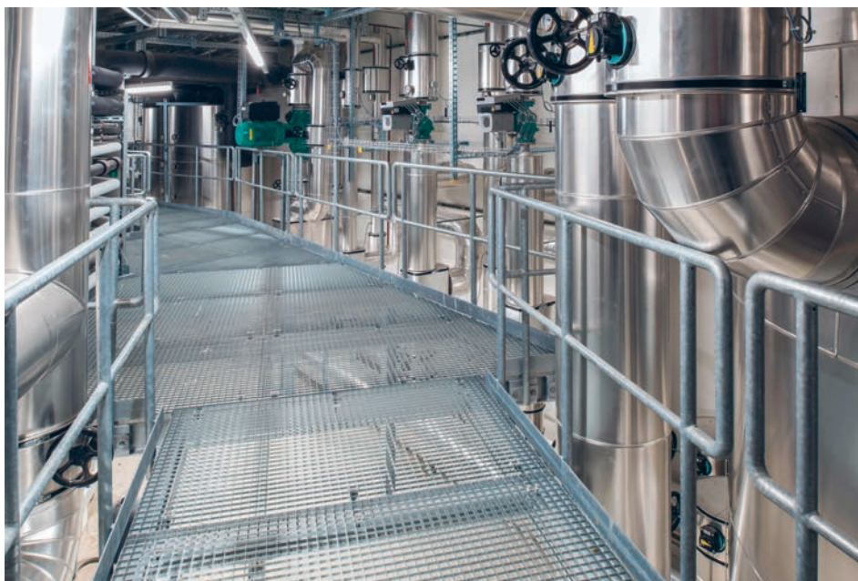
Les grilles caillebotis supportent une charge maximale de 500 kg/m 2 . Il importe également de contrôler les hauteurs de balustrade prescrites.
