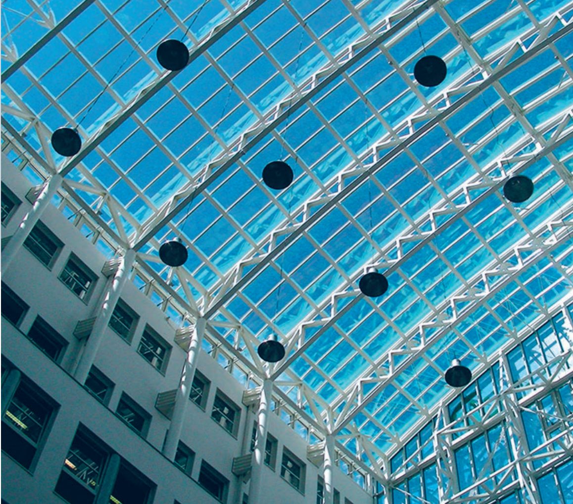
Die Neigung des Glasdachs im Firstbereich wurde auf einen Neigungswinkel steiler als 8° angepasst. L'inclinaison du toit au niveau du faîte a été adaptée pour être supérieure à 8°.
