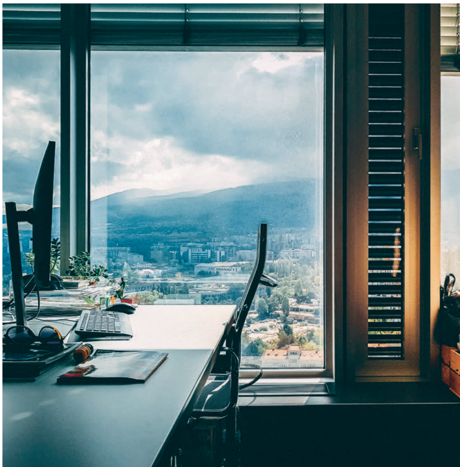
Absturzhemmende Verglasung bei Bürogebäude. Vitrage antichute d'un immeuble administratif.
