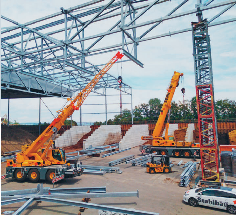
Montage der Aussenlagerüberdachung Ricoter, Aarberg. Montage de la toiture de l'entrepôt extérieur, Ricoter, Aarberg
