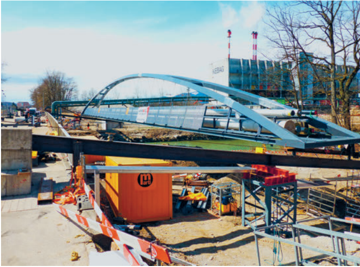
Verschub Werkleitungssteg Emme, Luterbach. Déplacement d'une passerelle à canalisations, Emme, Luterbach
