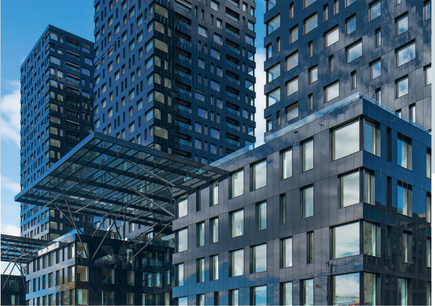
Beim Projekt «Vulcano» lieferte Schweizer die Fassade mit SSG-verklebten Glasverkleidungen mit Dämmung und Unterkonstruktion.
