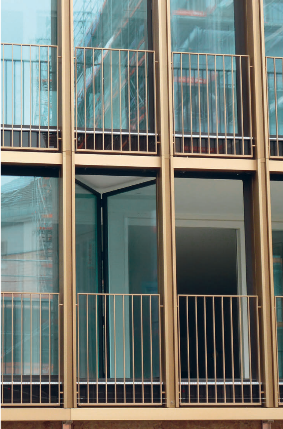
Aussenansicht des Wohntraktes. Gut zu erkennen sind die offenstehenden, gegen innen gefalteten Glasfaltwände.
