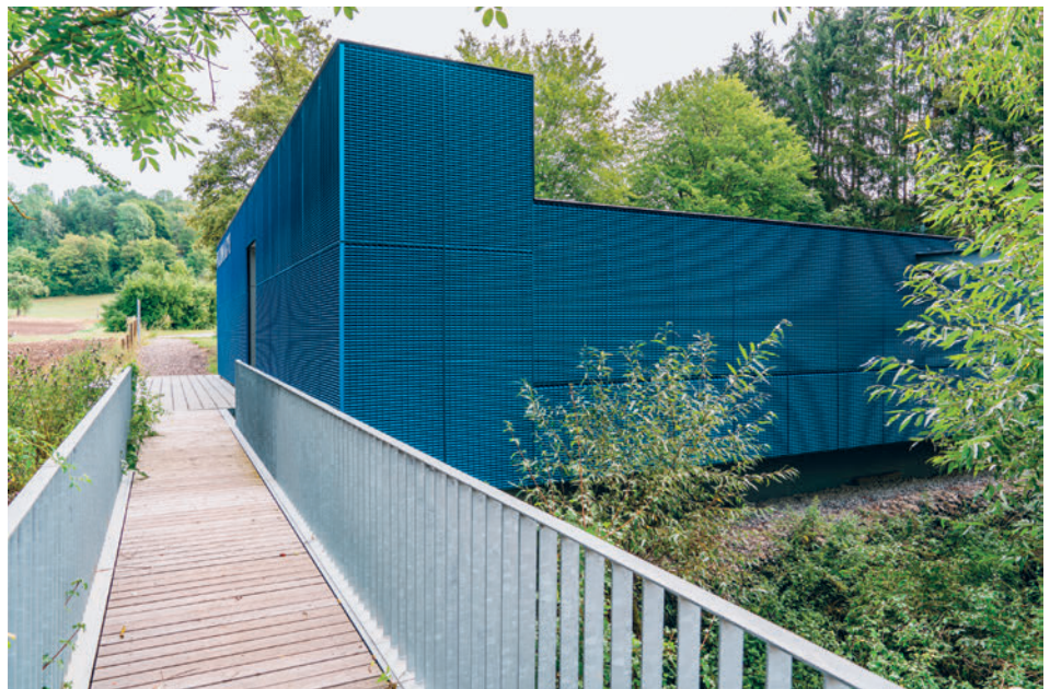
Um eine einheitliche Erscheinung aller Roste zu erreichen, wurde mit Musterrosten die Zeit der adsorptiven Färbung bestimmt und festgelegt.
