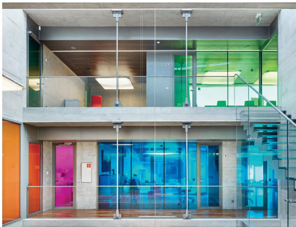
Profilsystem: Brandschutzverglasung Forster Fuego Light mit Glas-Glas-Stoss. Objekt: Raiffeisenbank Saxon Architektur: CEPA Sarl, Saxon Metallbau: Bitz & Savoye SA, Sion
