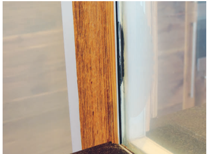
Verträglichkeitsproblem bei falscher Kombination unterschiedlicher Kunststoffe in der Rahmenkonstruktion. Problèmes de compatibilité en cas de mauvaise association de divers plastiques au niveau du cadre
